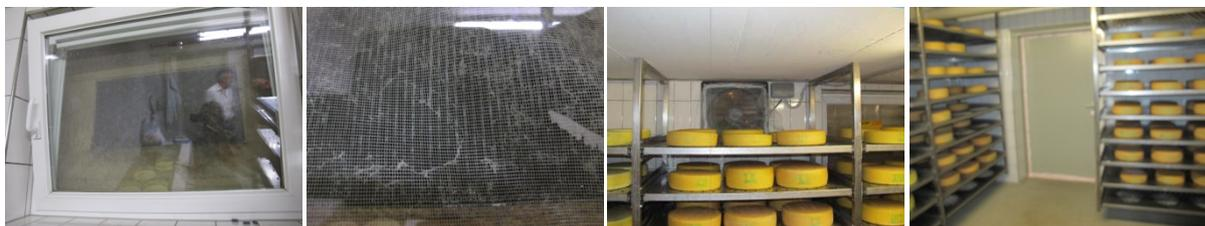
Abbildung 35: Fahrzeugkühler im Lichtschacht eines Fensters (links aussen und links Mitte) und Ventilator (rechts Mitte). Diese sind mit einem Fliegennetz versehen (links Mitte und rechts Mitte). Eine zweite Türe, die nicht verwendet wird, ist zusätzlich luftdicht verklebt (rechts aussen).
