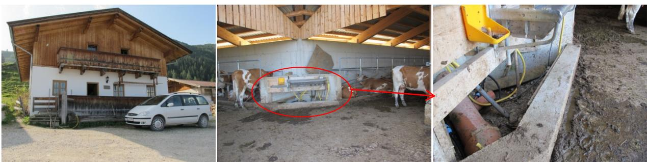
Abbildung 25: Die Gülleleitung zwischen den Liegehallen wird mit Abwasser aus dem höher liegenden Wohngebäude gespült, welches zwischen den Stallgebäuden in die Gülleleitung eingeleitet wird.
