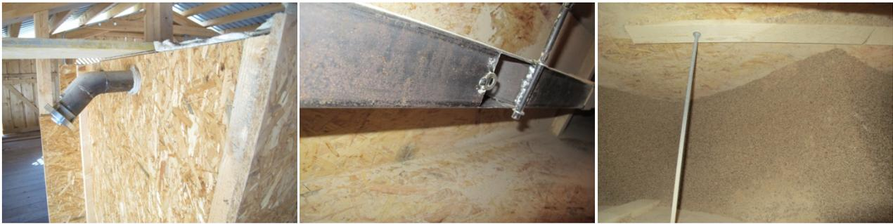
Abbildung 17: Der Einfüllstutzen an der Frontseite des Silos (links) führt in eine Leitung mit rechteckigem Querschnitt – wie ein Blick an die Silodecke zeigt (Mitte). Die Leitung verläuft über die komplette Länge des Silos an dessen Decke und verfügt über mehrere Öffnungen, die über Klappen geöffnet und geschlossen werden können. Dies sorgt für eine gleichmässige Silobefüllung (rechts).
