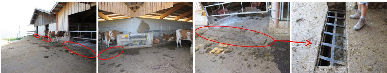
Abbildung 23: Am Ende der Laufgänge zwischen Liegehalle und Laufhof sind Abwurfluken in die Spülleitungen angeordnet. Diese werden mit Metallplatten abgedeckt und zusätzlich mit einem Metallgitter gesichert. Die Entmistung der planbefestigten Flächen wird mit einem Hoftraktor durchgeführt.
