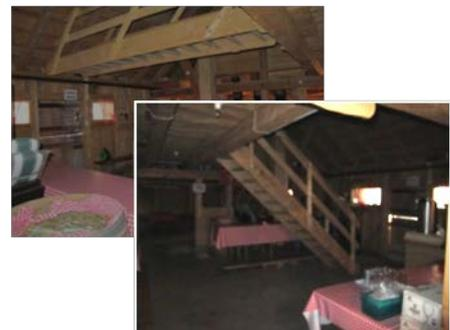
Abbildung 50: Treppe zum ersten Stock in hochgezogenem und herabgelassenem Zustand.
