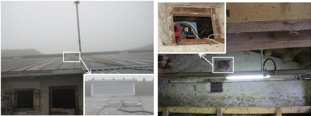
Abbildung 55: Rasensprenger zur Dachberegnung und Ventilatoren zur Kühlung des Stallgebäudes.
