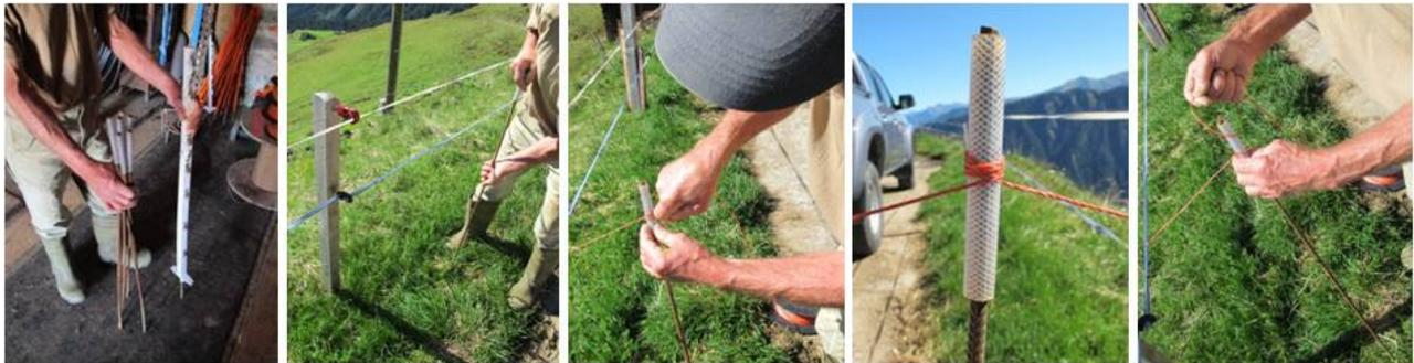
Abbildung 7: Selbstbau-Zaunpfähle im Vergleich zu einem konventionellen Weidezaunpfahl (links aussen). Zum Aufbau werden die Pfähle in den Boden gedrückt (links Mitte) und die Zaunlitze sorgfältig um den mit Schlauch isolierten Teil des Pfahls gewickelt (Mitte, rechts Mitte). Zum Abbau des Zaunes wird die Litze nach oben abgezogen (rechts aussen).
