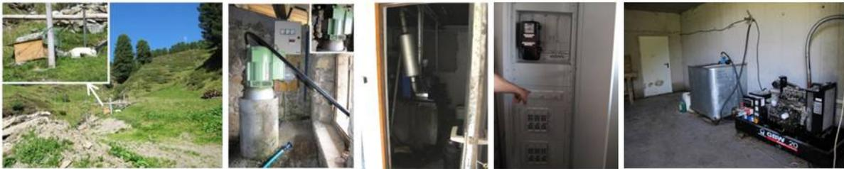
Abbildung 43: Stromversorgung über Kraftwerke (links aussen; links Mitte; Mitte), Schaltpult zum Umschalten der Stromversorgung (rechts Mitte) und Dieselaggregat (rechts aussen).
