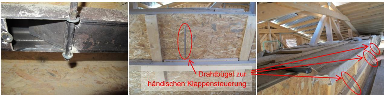
Abbildung 18: Um für eine gleichmässige Verteilung über die ganze Länge des Silos zu sorgen, kann der Futter-Luftstrom über Klappen gesteuert werden (links). Die Klappen werden durch einen Drahtbügel an der Aussenseite des Silos von Hand bedient (Mitte und rechts).
