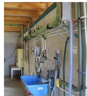
Abbildung 15: Sichtbar verlegte Wasserrohre erleichtern das Auffinden von Lecks sowie die Reparatur.
