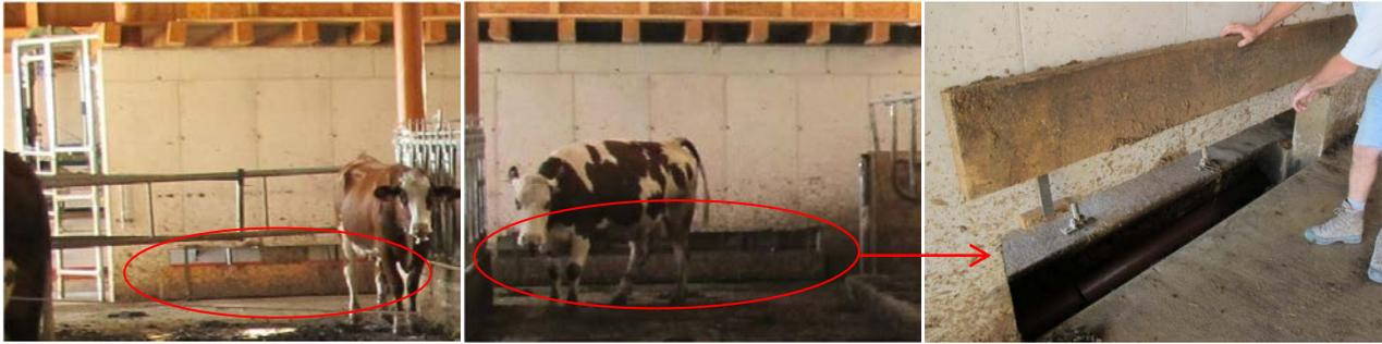
Abbildung 22: Melkstand und Stall haben eine gemeinsame Wand, in der sich Abwurfluken für den Mist befinden, der von den planbefestigten Laufgängen maschinell abgeschoben wird. Eine Holzabdeckung, die zur Entmistung geöffnet wird, schützt die Tiere.
