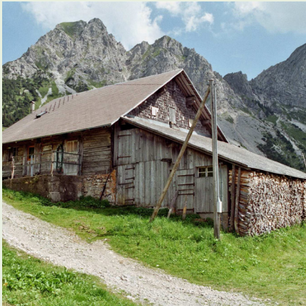
Alp Jänzimatt, Gilgenhütte, Obwalden
